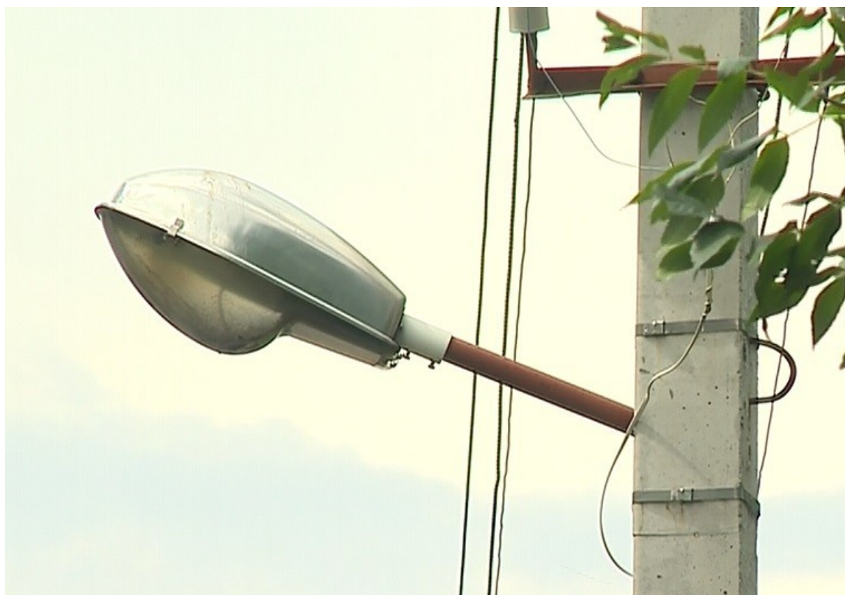
Рисунок 4 - Светильник, снабжённый рельефным плафоном
