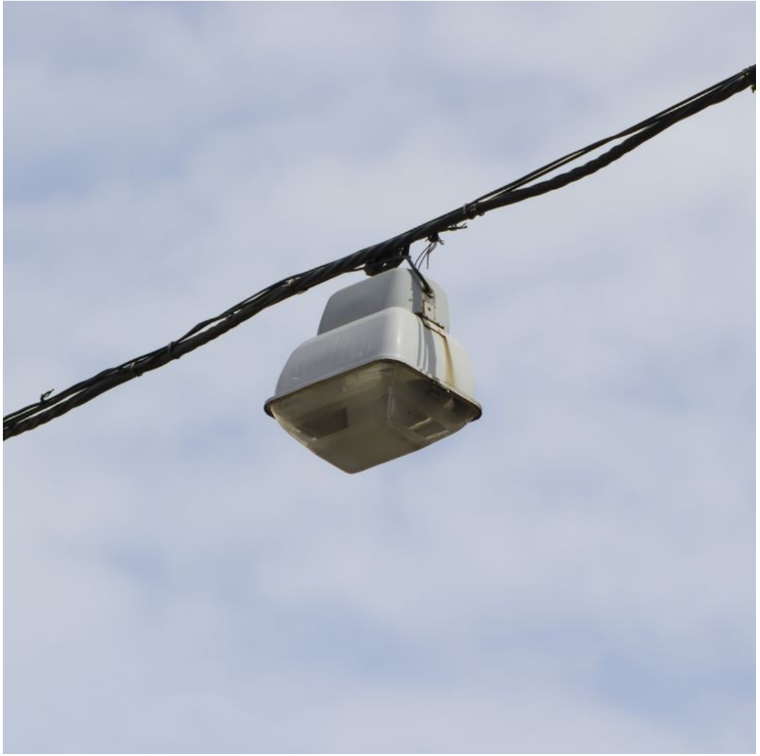
Рисунок 5 - Светильник, подвешенный на струне
