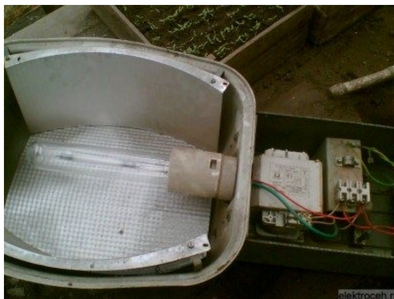
Рисунок 3 - Устройство уличного светильника с лампой ДНаТ
