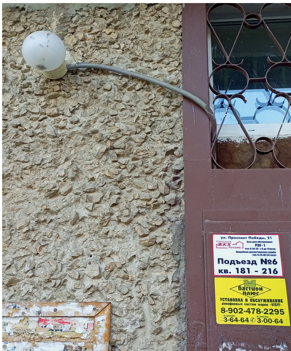
Рисунок 7 – Наличие освещения над входом в подъезд
